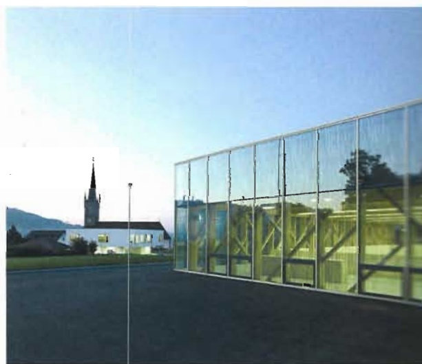
5...La construction de la salle de gymnastique d'Attalens s'inscrit dans l'agrandissement global de l'école du village.
